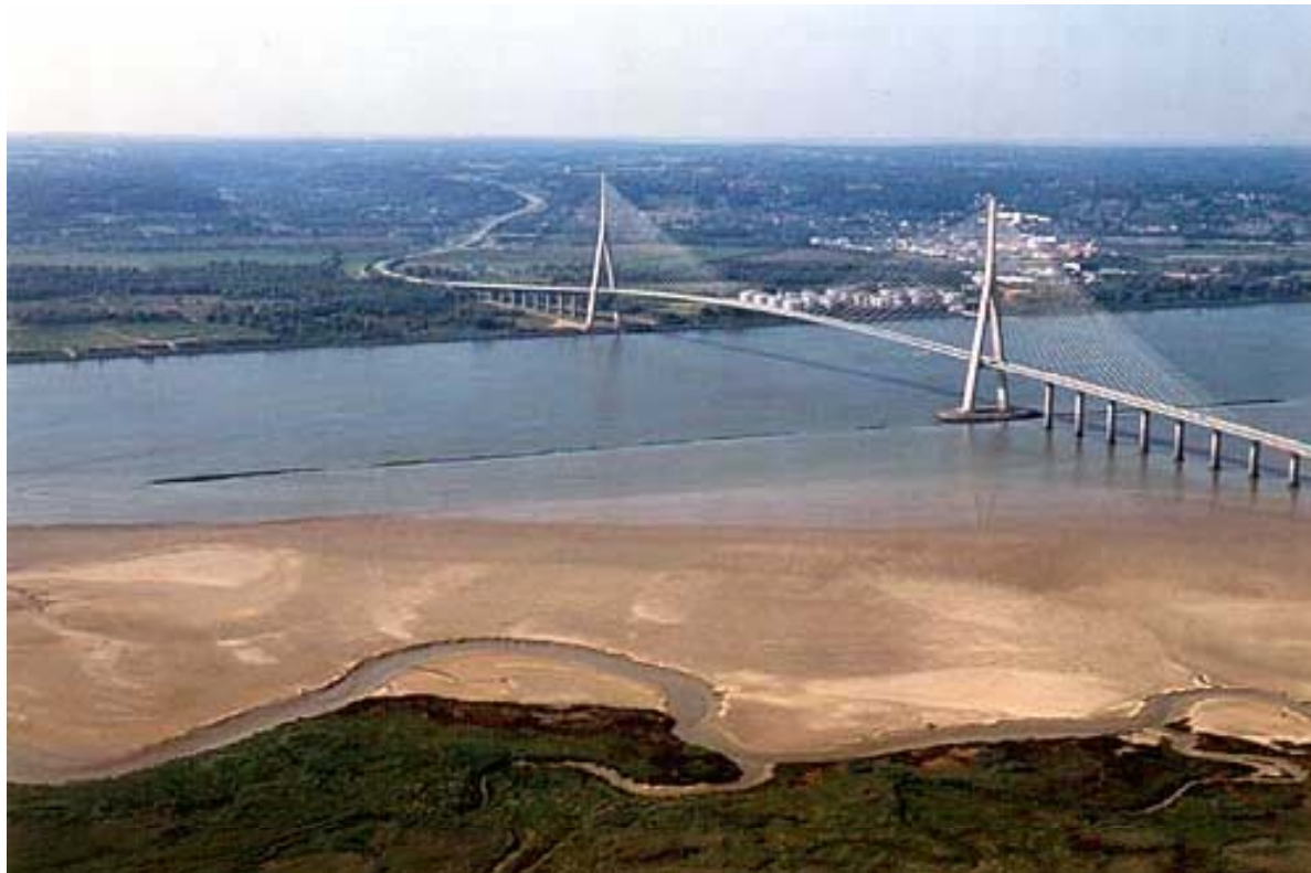
Pont de Normandie, France
