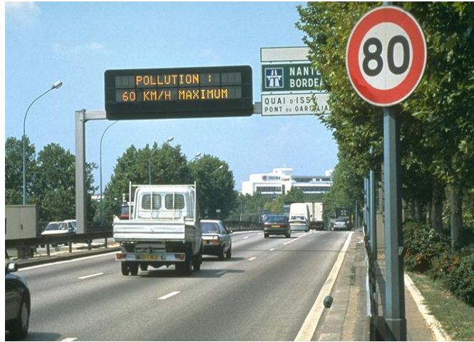
Şekil 6.2. Sabit hız sınırı levhaları ve değişken hız sınırı levhaları arasındaki uyumsuzluk örneği
